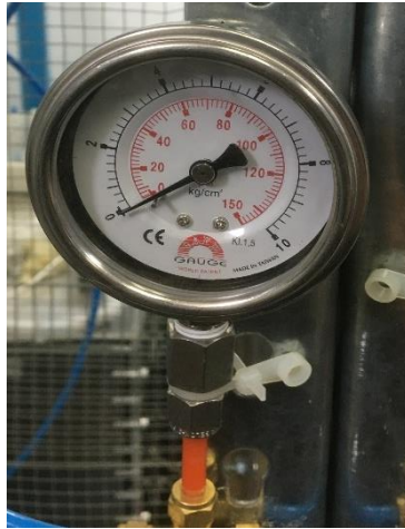
圖五、指針式正壓氣壓計
